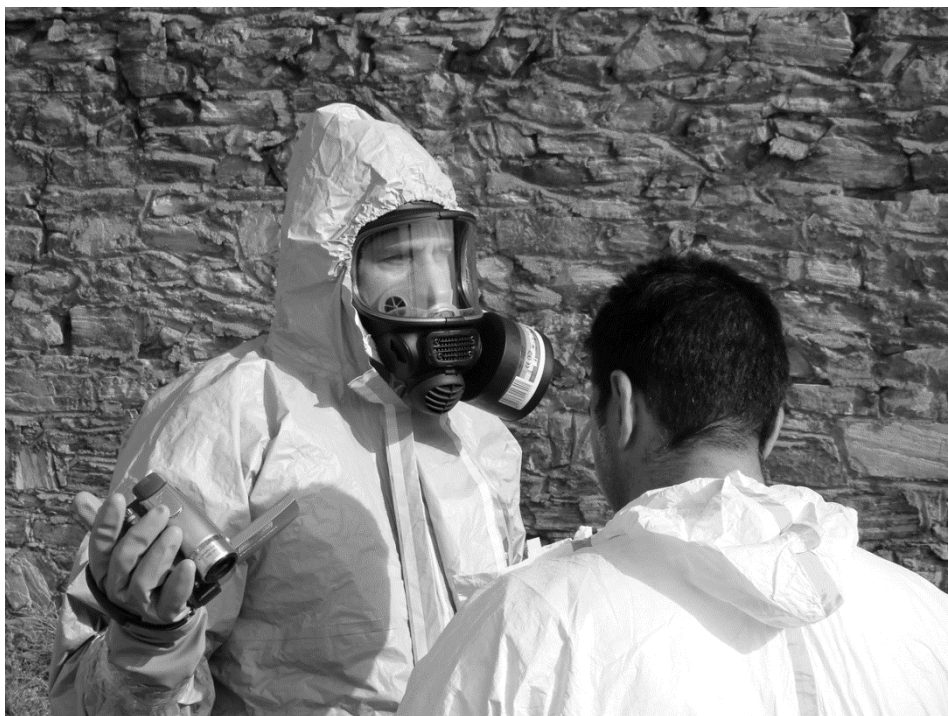
Φωτογραφία 1. Προετοιμασία για την είσοδο στο κτήριο Κονοφάγου. Έλεγχος στεγανότητας ειδικής στολής.
