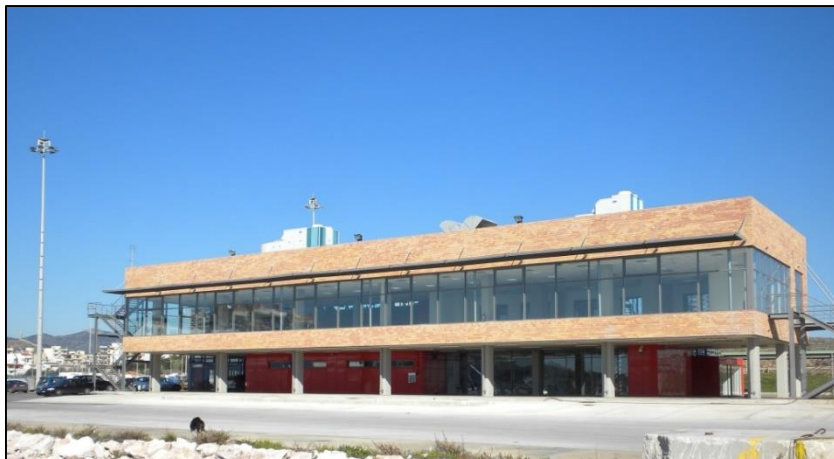
Εικόνα 1. Νότια όψη επιβατικού σταθμού πλοίων νέας τεχνολογίας
