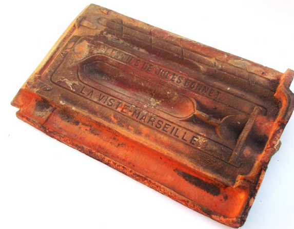
Εικ.: 40 Γαλλικό κεραμίδι της στέγης του κτηρίου 34 Δ, προερχόμενο από τη Μασσαλία. (Κατασκευαστής: Les fils de Jules Bonnet, La Viste, Marseille) Fig.: 40 French roof tile from building 34D, coming from Marseille. (Produced by: Les fils de Jules Bonnet, La Viste, Marseille)
